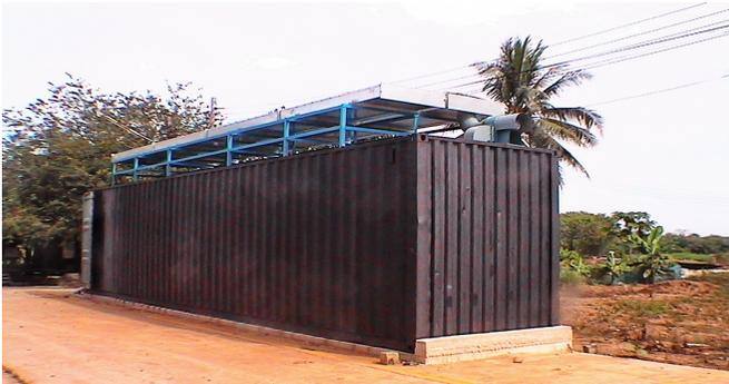
Cámara de secado solar de caucho, Tailandia
