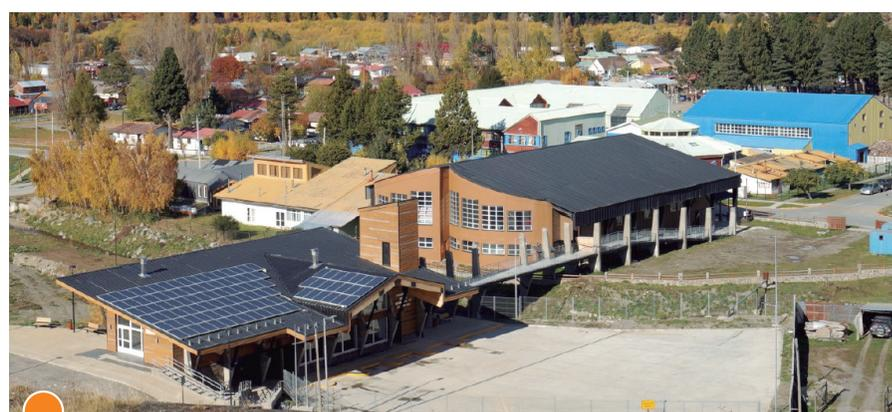
28 kWp Photovoltaik-Anlage auf dem Busterminal in Cochrane, Región de Aysén
