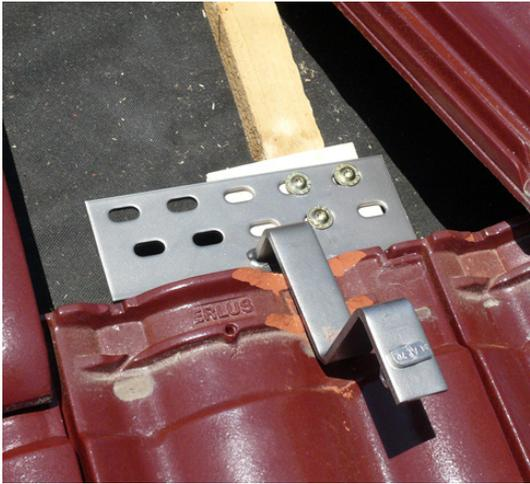
Gesetzter Dachhaken mit unterlegtem Ausgleichsholz zum Höhenausgleich
