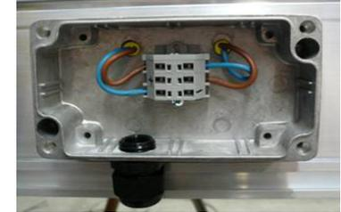
Abb.2: Modulanschlussdose am Kollektor (hier 2 Module)
