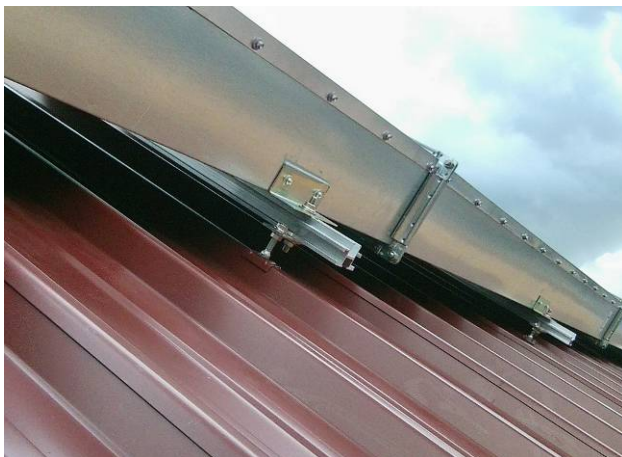
III. 17: Exemples de capteurs standards JUMBOSOLAR installés sur toitures inclinées
