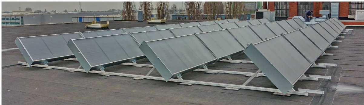
III. 23: Installation standard GLK sur toiture terrasse
