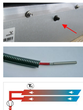
III. 44: Sonde du capteur - emplacement
