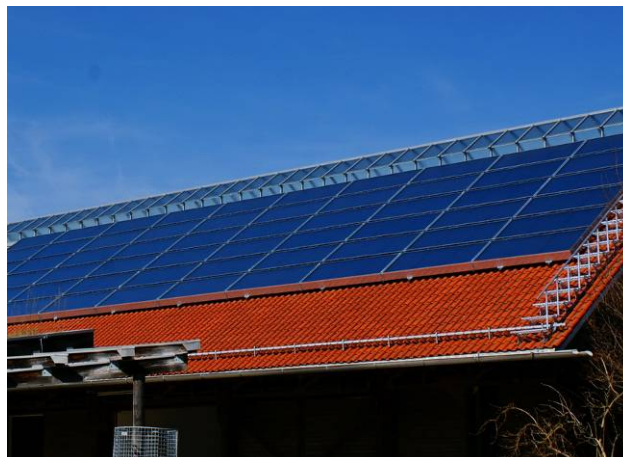
III. 17: Exemples de capteurs standards JUMBOSOLAR installés sur toitures inclinées
